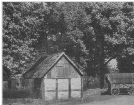
Zollschuppen in der Nähe der Stiftsmühle, leider abgerissen, Aufnahme von 1929
